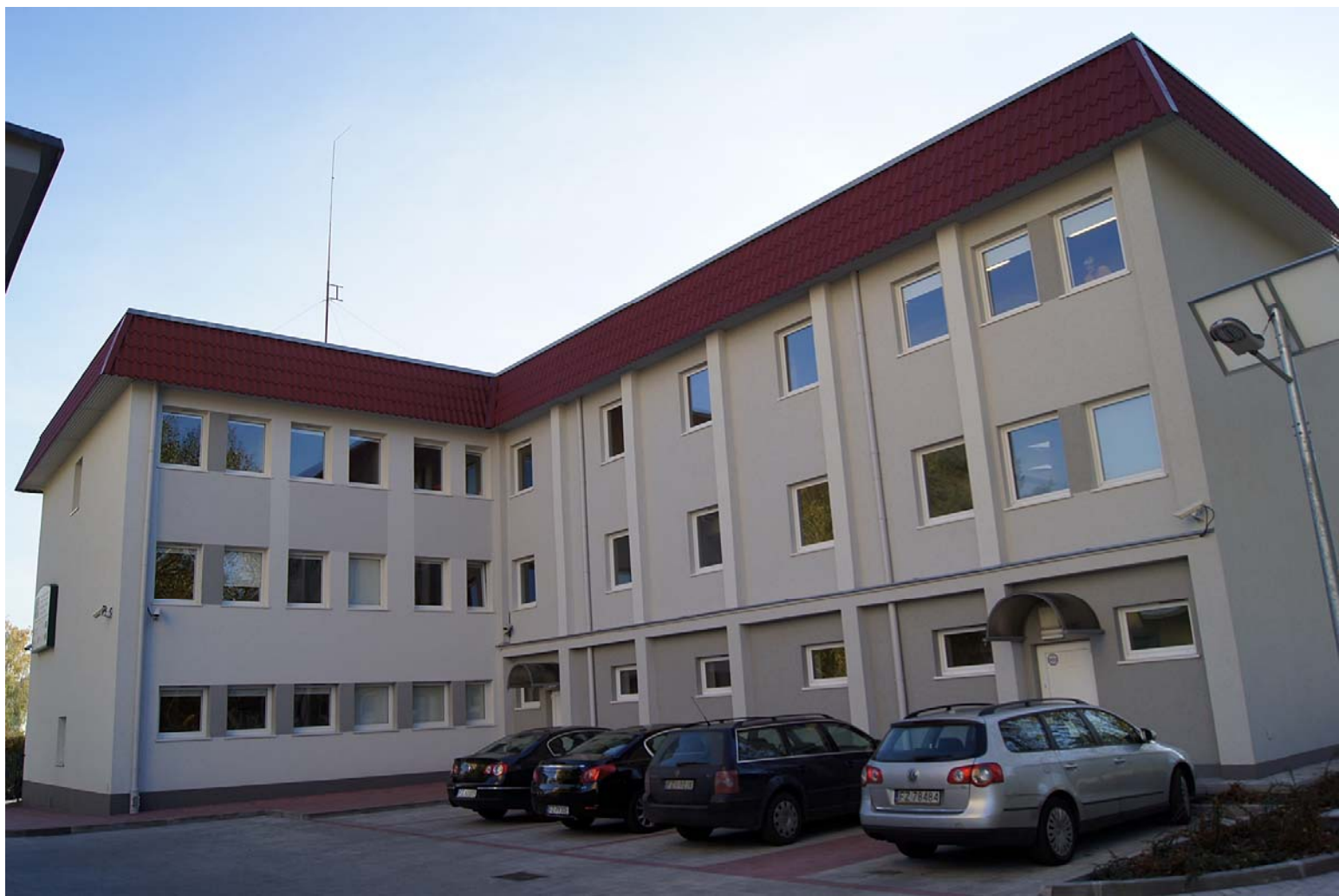
Budynek administracyjno-biurowy – tył
